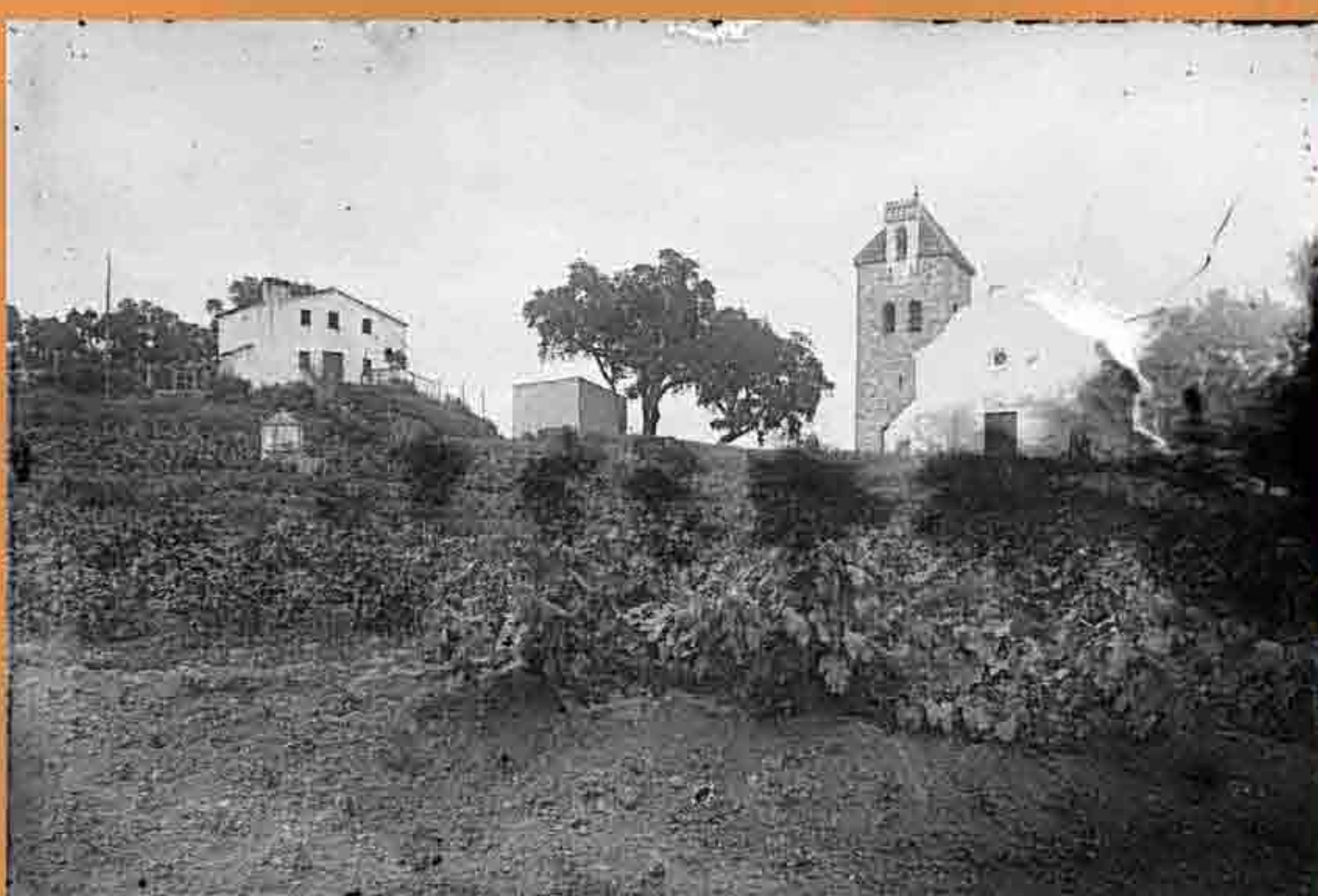
Santuari de les Alegries abans de ser restaurat, amb unes vinyes en primer terme (c. 1930)
