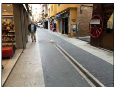
Tram 115: Carrer de la Vila
