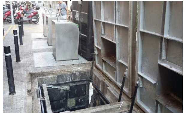
FOTOS 11 i 12: Buidat d'aigua acumulada i neteja dels contenidors soterrats amb l'ajuda del camió cubà de l'empresa Cubes i Contenedors Pallarès.
