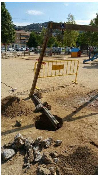
FOTOS 101 i 102: Canvi d'un pal trencat de l'estructura del gronxador del parc infantil del Rieral.
