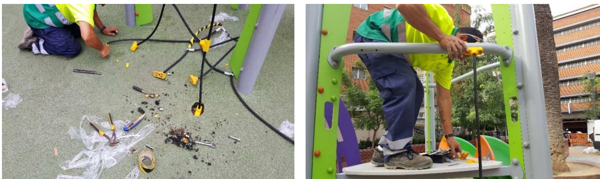
FOTOS 99 i 100: Instal·lació de l'escala de corda del joc de torre del parc infantil de Germans Maristes.
