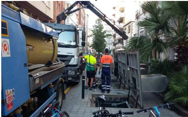
FOTOS 11 i 12: Buidat d'aigua acumulada i neteja dels contenidors soterrats amb l'ajuda del camió cubà de l'empresa Cubes i Contenedors Pallarès.
