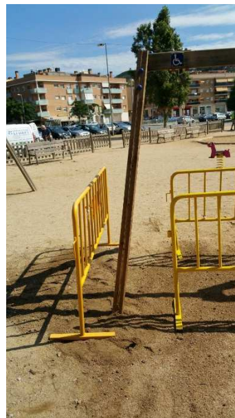
FOTOS 101 i 102: Canvi d'un pal trencat de l'estructura del gronxador del parc infantil del Rieral.
