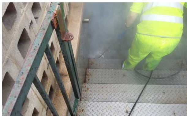
FOTOS 59 i 60: Neteja amb aigua calenta a pressió de les escales d'accés al magatzem situat sota el passeig Camprdon i Arrieta.
