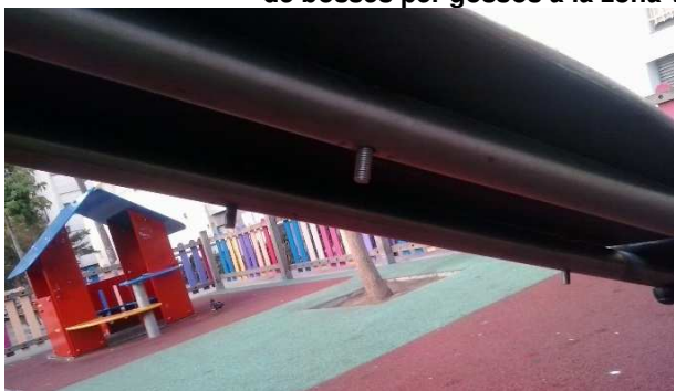
FOTOS 129 i 130:.. Cargols robats a la rampa d'accés a la torre del parc infantil dels Drets Humans i posterior col·locació de nous amb tap de protecció.
