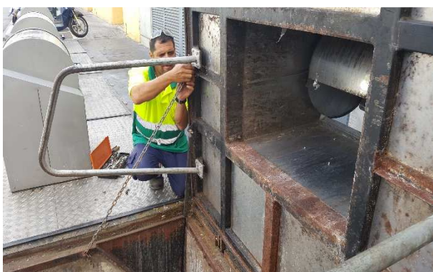
FOTOS 39 i 40: Reparació de les cadenes de la comporta d'un contenidor soterrat d'envasos al carrer Hipólito Lázaro i neteja del fossat.
