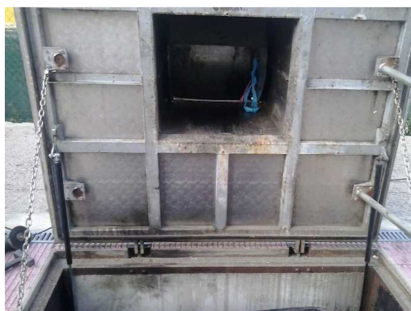
FOTOS 33 i 34: Nova àrea de selectiva a la carretera de Blanes, cantonada amb carrer Riu de la Plata, i reparació dels esmorteïdors d'un contenidor de paper-cartró a Mas Arboç.
