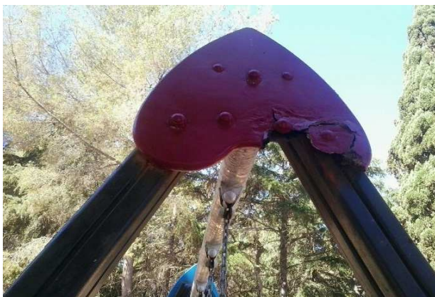
FOTOS 125 i 126: Canvi d'un suport de fusta deteriorat del gronxador del parc infantil de Doña Elvira.
