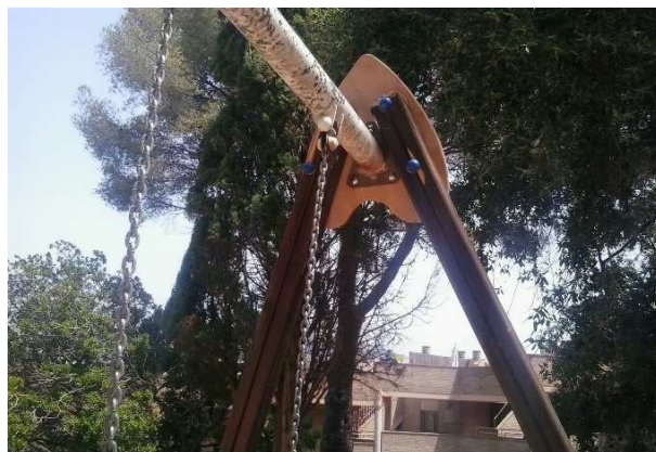
FOTOS 125 i 126: Canvi d'un suport de fusta deteriorat del gronxador del parc infantil de Doña Elvira.
