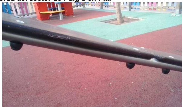
FOTOS 129 i 130:.. Cargols robats a la rampa d'accés a la torre del parc infantil dels Drets Humans i posterior col·locació de nous amb tap de protecció.
