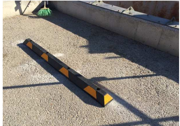
FOTO 149 i 150: Amidaments per col·locar un topall al voltant dels contenidors per evitar que els vehicles s'acostin massa al límit del moll de descàrrega. Topalls instal·lats en el moll de descàrrega.
