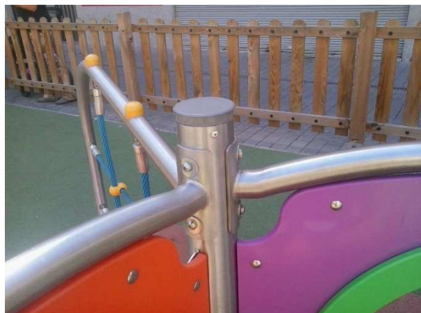
FOTOS 117 i 118: Trencament d'un tap de seguretat al parc infantil de la plaça Melcior Montero i col·locació d'un provisional a l'espera de recanvi original.
