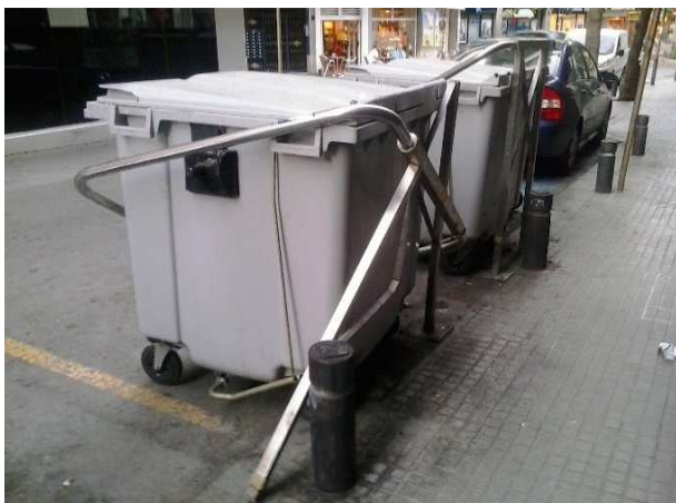
FOTOS 17 i 18: Fixació trencada per un vehicle al carrer Anselm Clavé i posterior canvi per una de nova.
