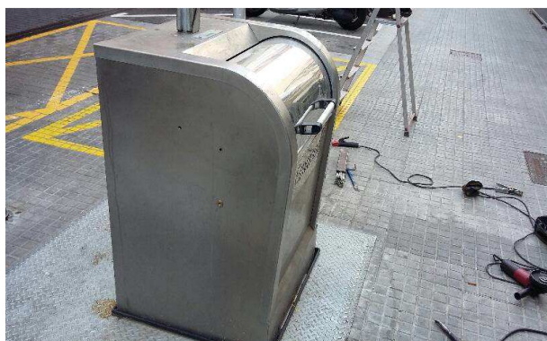
FOTOS 23 i 24: Reparació de l'estructura de seguretat del contenidor soterrat d'envasos de la plaça Espanya
