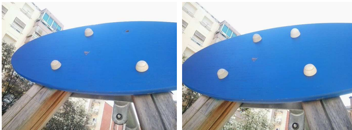
FOTOS 91 i 92: Reposició de cargols robats a l'estructura del gronxador del parc infantil dels Drets Humans.
