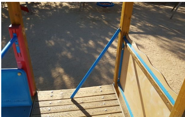
FOTOS 107 i 108: Barra metàl·lica trencada per uns desconeguts al joc principal del parc infantil de la plaça Esteve Fàbregas i posterior reparació.
