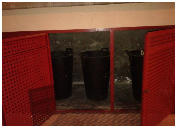
FOTOS 5 i 6: Cambres d'escombraries amb cubells. Cal indicar que les mides de la cambra (sobretot la poca alçada d'aquesta) dificulta la recollida per part dels operaris en matèria preventiva.
