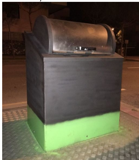
FOTOS 15 i 16: Desgasts produït per l'oxidació de les xapes metàl·liques dels contenidors de rebuig ubicats a l'avinguda Narcís Macià i Domènec i, posterior reparació.
