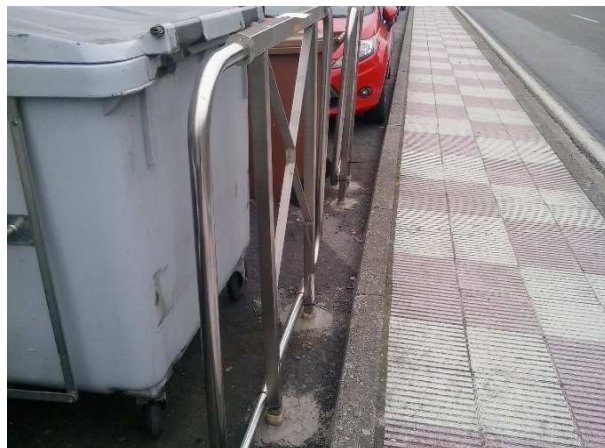
FOTOS 5 i 6: Fixació arrancada i tallada per la base a la carretera de Blanes, davant el número 101, i posterior reparació.
