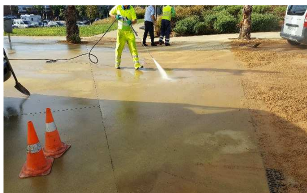
FOTOS 37 i 38: Retirada de sorres i fang i neteja amb aigua a pressió de l'entrada de formigó del teatre.
