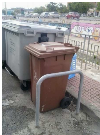
FOTOS 13 i 14: Canvi d'una fixació arrencada a l'avinguda del Rieral, cantonada amb el carrer del Molí.
