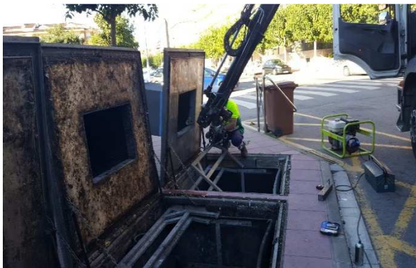
FOTOS 33 i 34: Reparació i manteniment de contenidors soterrats de selectiva i recollida de vidre d'un gran productor amb un iglú Vacry i bujol específic per buidar a dins.
