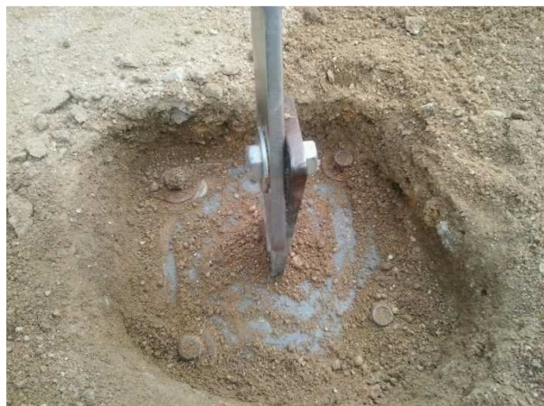
FOTOS 89 i 90: Cable d'acer deteriorat d'un ancoratge de l'estructura de la tirolina de Can Sabata i posterior canvi i millora amb una platina i cargol d'acer inoxidable.
