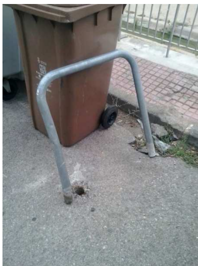
FOTOS 13 i 14: Canvi d'una fixació arrencada a l'avinguda del Rieral, cantonada amb el carrer del Molí.
