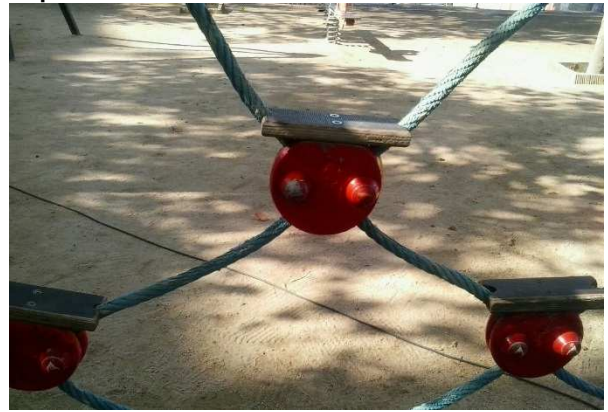
FOTOS 95 i 96: Reposició dels posa-peus de fusta de la xarxa d'escalada del parc.
