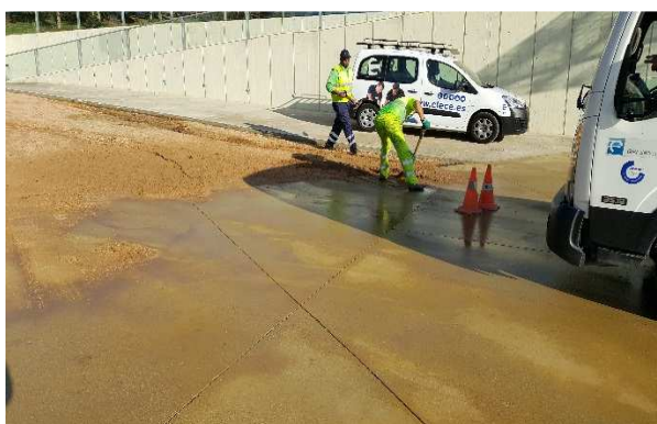
FOTOS 37 i 38: Retirada de sorres i fang i neteja amb aigua a pressió de l'entrada de formigó del teatre.
