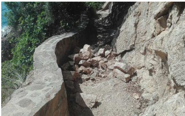
FOTOS 83 i 84: Retirada de pedres caigudes al camí de ronda entre el Castell i cal d'en Trons.
