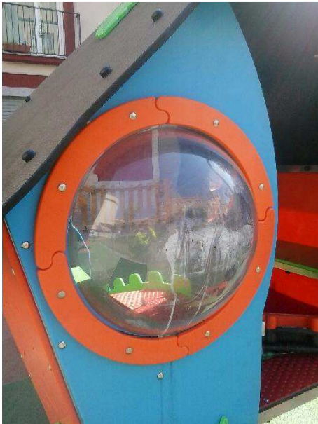
FOTOS 93 i 94: Trencament d'un ull de bou de la caseta del parc infantil de la plaça Melcior Montero i posterior reparació provisional amb un tall de metacrilat pla fet a mida fins que arribi recanvi original.
