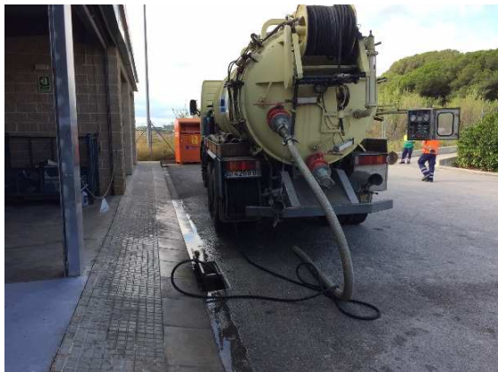
FOTO 119: Buidat i neteja d'un embornal obstruït.
