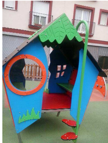
FOTOS 93 i 94: Trencament d'un ull de bou de la caseta del parc infantil de la plaça Melcior Montero i posterior reparació provisional amb un tall de metacrilat pla fet a mida fins que arribi recanvi original.
