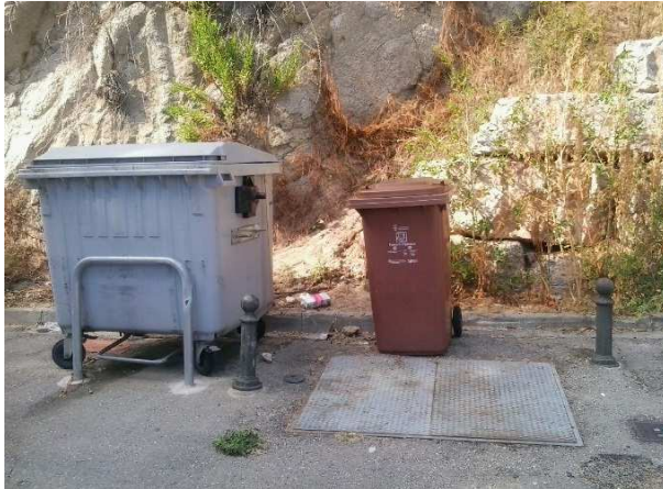
FOTOS 11 i 12: Retirada d'unes pilones al voltant d'un contenidor de Rocagrossa i col·locació d'una protecció en forma de "U".
