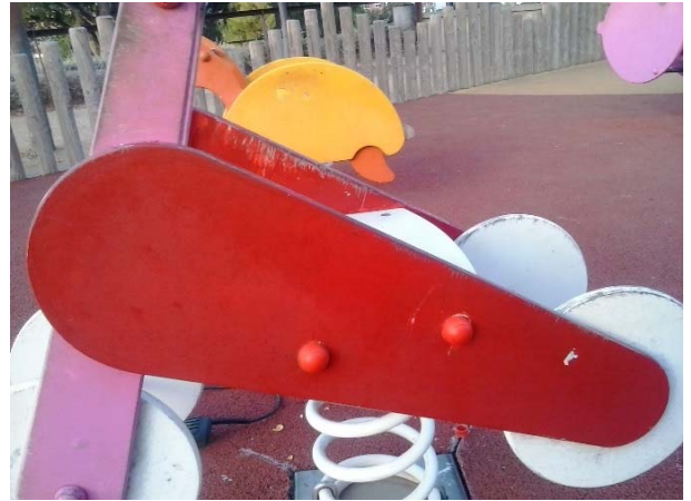
FOTOS 115 i 116: col·locació de cargols robots a un element del parc infantil de Can Xardó .
