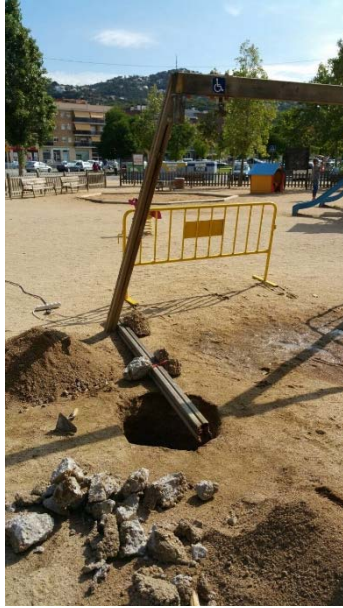
FOTOS 101 i 102: Canvi d'un pal trencat de l'estructura dels gronxadors del parc infantil del Rieral.
