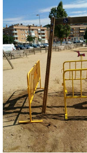
FOTOS 101 i 102: Canvi d'un pal trencat de l'estructura dels gronxadors del parc infantil del Rieral.
