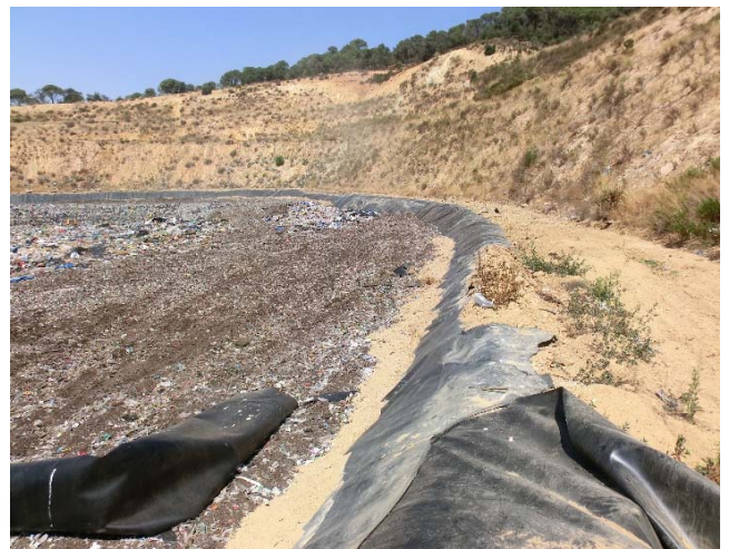
FOTOS 14 i 17: Diferents imatges de la reparació de la lamina d'impermeabilització del talús est de la cel·la. La làmina es va despenjar de la coronació del talús. Es va ancorar de nou i es van soldar les parts de la unió que es van trencar.
