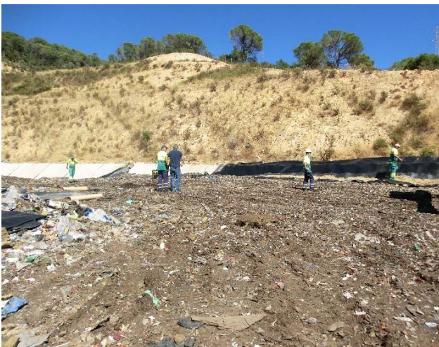
FOTOS 14 i 17: Diferents imatges de la reparació de la lamina d'impermeabilització del talús est de la cel·la. La làmina es va despenjar de la coronació del talús. Es va ancorar de nou i es van soldar les parts de la unió que es van trencar.
