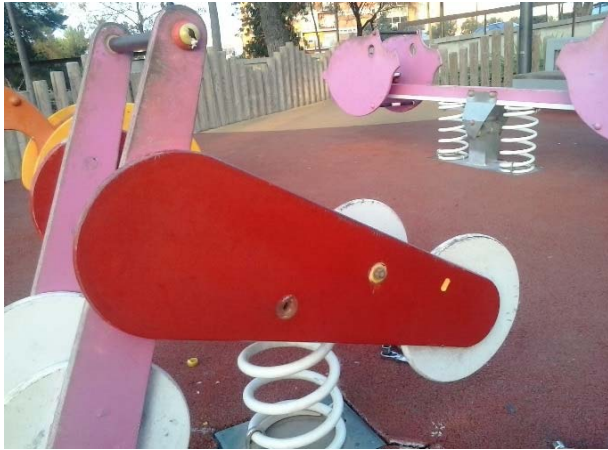
FOTOS 115 i 116: col·locació de cargols robots a un element del parc infantil de Can Xardó .
