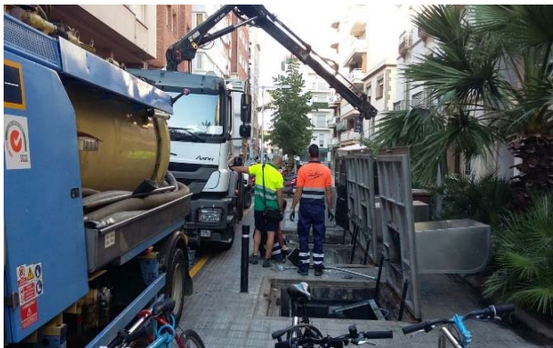
FOTOS 11 i 12: Buidatge d'aigua acumulada i neteja dels contenidors soterrats amb l'ajuda del camió cubà de l'empresa Cubes i Contenidors Pallarés.
