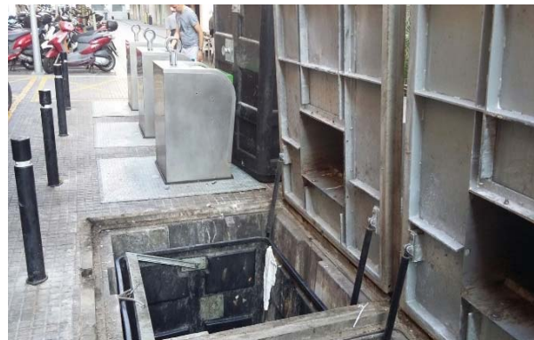
FOTOS 11 i 12: Buidatge d'aigua acumulada i neteja dels contenidors soterrats amb l'ajuda del camió cubà de l'empresa Cubes i Contenidors Pallarés.
