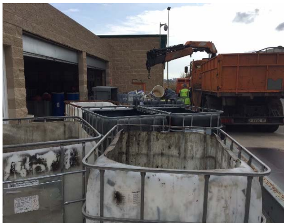
Foto 1: Recollida de residus especials amb camió-grua.
