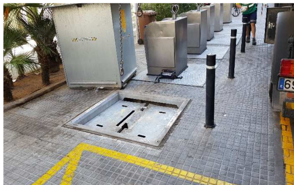
FOTOS 39 i 40: Neteja dels fossats dels contenidors soterrats de selectiva i reparació de les comportes de seguretat del contenidor soterrat d'envasos de la plaça Espanya.
