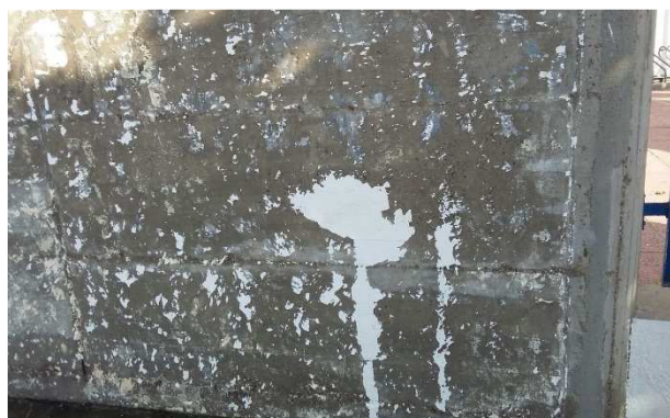
FOTOS 71 i 72: Retirada de la pintura plàstica del mur de formigó del parc del carrer Barcelona per poder pintar un mural.
