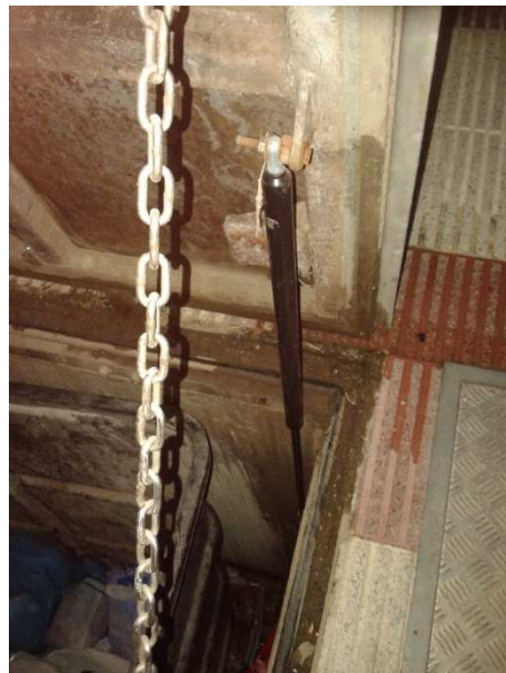
FOTOS 25 i 26: Reparació de l'esmorteïdor d'un contenidors soterrat d'escombraries.
