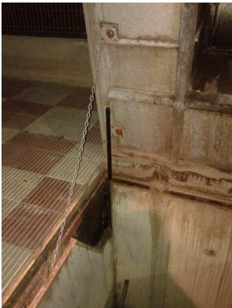
FOTOS 25 i 26: Reparació de l'esmorteïdor d'un contenidors soterrat d'escombraries.
