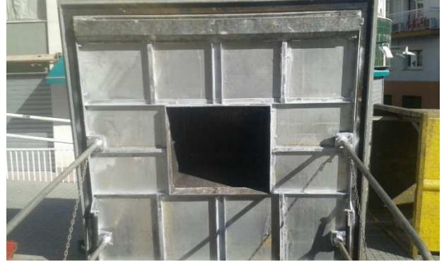
FOTOS 27 i 28: Reparació de la comporta d'un contenidor soterrat d'envasos al carrer Potosí.
