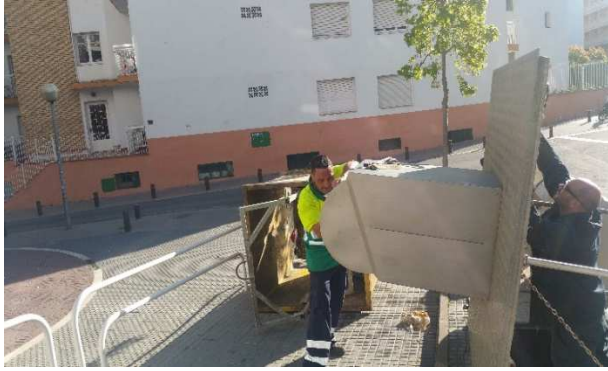
FOTOS 27 i 28: Reparació de la comporta d'un contenidor soterrat d'envasos al carrer Potosí.
