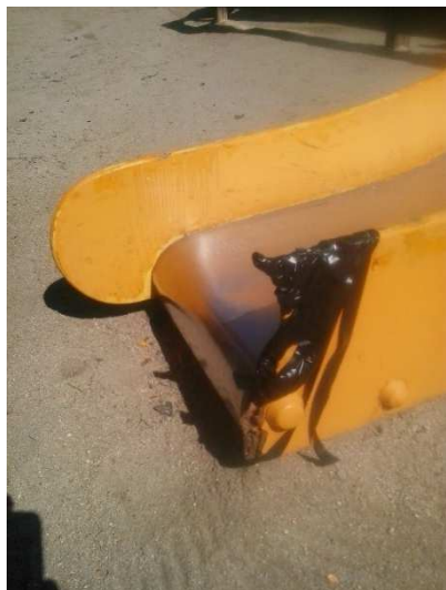
FOTOS 87 i 88: Trencament, per part d'uns desconeguts, de la fusta lateral del tobogan del parc infantil de Doña Elvira i posterior sanejament del tram afectat.
