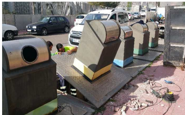
FOTOS 31 i 32: Reparació d'un contenidor soterrat d'envasos al carrer Santiago de Cuba.
