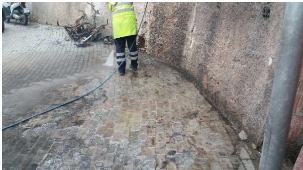
FOTOS 43 i 44: Neteja amb aigua calenta a pressió de la vorera del C/ Alexandria i detall del deteriorament de les llambordes per l'alta temperatura a que van estar sotmeses pel foc dels vehicles cremats
