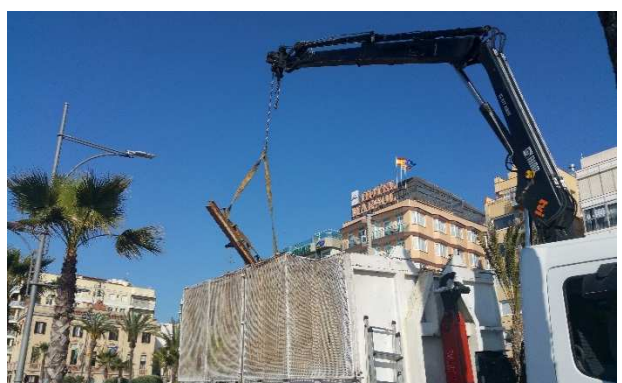
FOTOS 77 - 80: Estructura de ferro que va portar l'aigua a la vora de l'aigua, davant de l'Ajuntament, i tasques dutes a terme, amb el camió ploma per treure-la de l'aigua.
