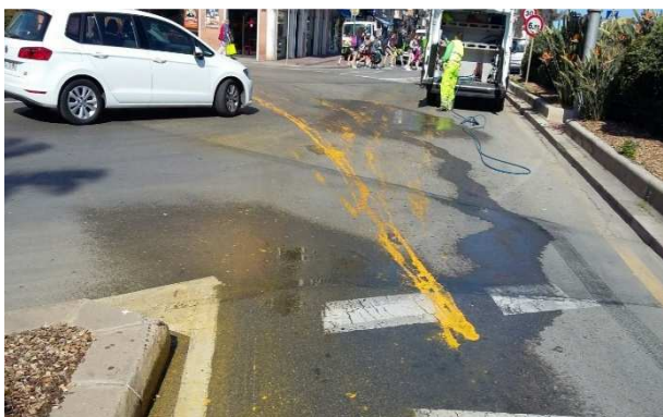
FOTOS 49 i 50: Taca de pintura caiguda al paviment de la rotonda de Just Marlés i posterior intervenció amb l'equip d'aigua calenta a pressió per eliminar-la.
