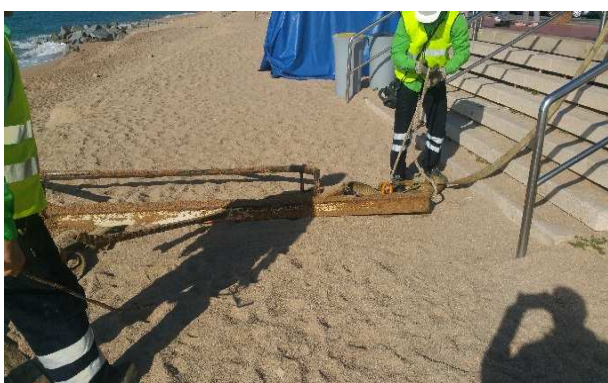
FOTOS 77 - 80: Estructura de ferro que va portar l'aigua a la vora de l'aigua, davant de l'Ajuntament, i tasques dutes a terme, amb el camió ploma per treure-la de l'aigua.
