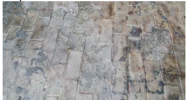
FOTOS 43 i 44: Neteja amb aigua calenta a pressió de la vorera del C/ Alexandria i detall del deteriorament de les llambordes per l'alta temperatura a que van estar sotmeses pel foc dels vehicles cremats
