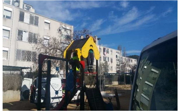
FOTOS 93 i 94: Canvi de fustes deteriorades dels elements del parc infantil de Can Ribalaigua.
