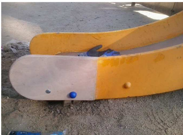
FOTOS 89 i 90: Col·locació d'un tram de fusta nova fet a mida i posterior pintada.
