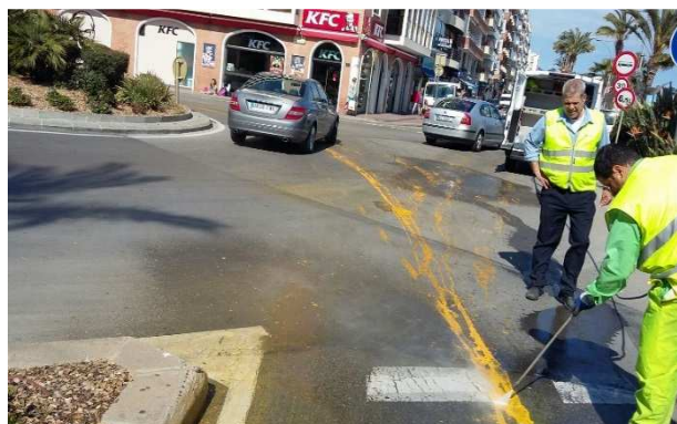
FOTOS 49 i 50: Taca de pintura caiguda al paviment de la rotonda de Just Marlés i posterior intervenció amb l'equip d'aigua calenta a pressió per eliminar-la.
