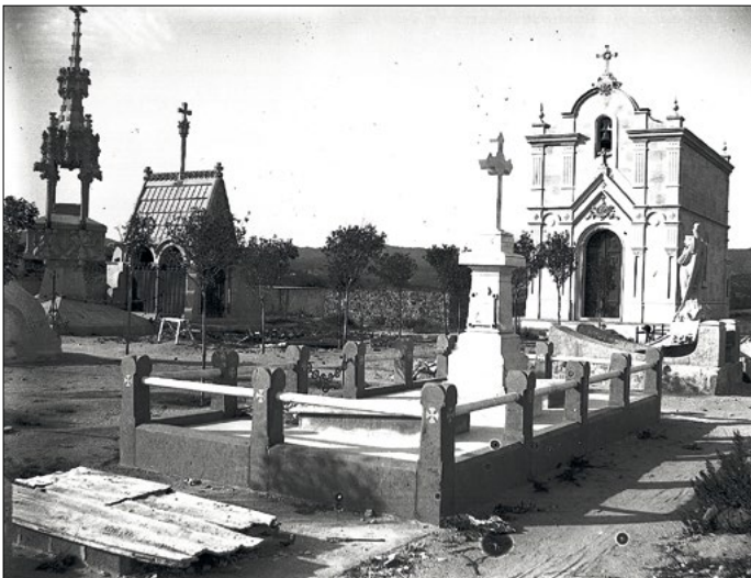
Construcció de panteons i hipogeus al Cementiri de Lloret de Mar. 1910 ca Procedència: SAMLM - Fons: Guimart-Ball·llatinas-Xiberta. Autor: Desconegut ST 320.001.12
