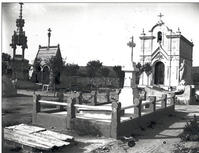
Construcció de panteons i hipogeus al Cementiri de Lloret de Mar. 1910 ca Procedència: SAMLM - Fons: Guimart-Ball·llatinas-Xiberta. Autor: Desconegut ST 320.001.12
