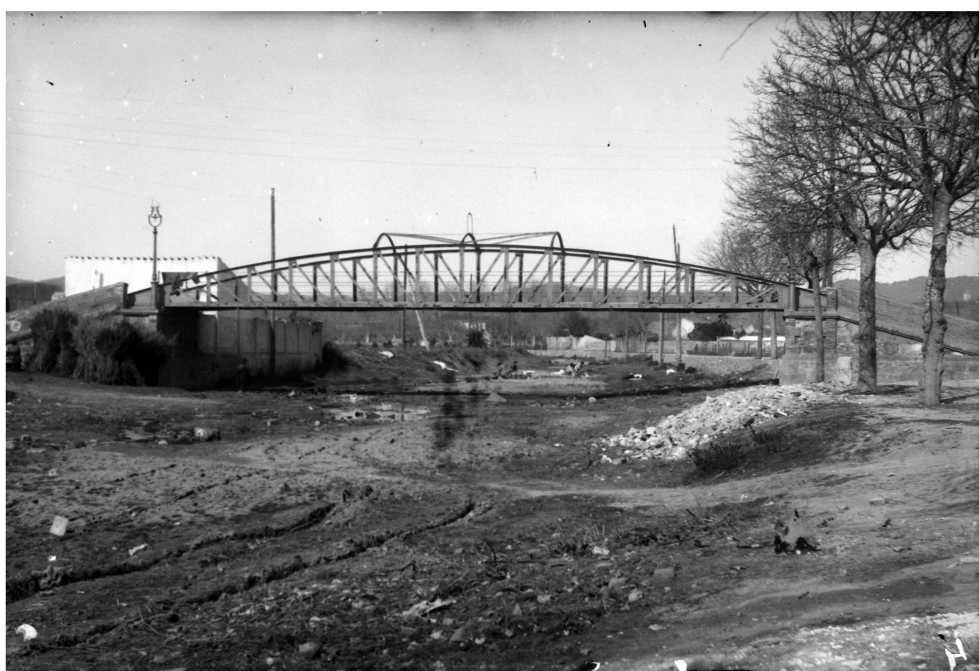
Perspectiva general del puente de hierro en una temporada en que la riera bajaba con poco caudal, ca. 1930. Autor y fondo: Ernest Xifra i Girbal. SAMLM. Servicio de Archivo Municipal de Lloret de Mar. S. T.: 304.018.011.
